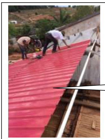
Pose des tôles face arrière
