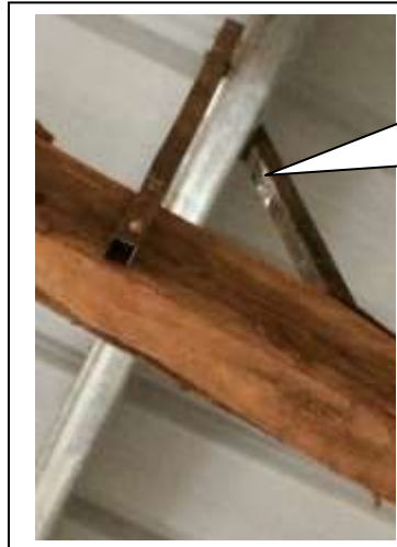
Renforcement des pannes avec des bouts de pannes restantes
