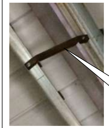
Renforcement des pannes centrales avec une cornière vissée
