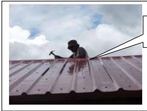
Injection de silicone par Naivo pour améliorer l'étanchéité de la faitière
