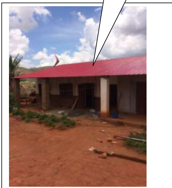
Fin de la pose des tôles
