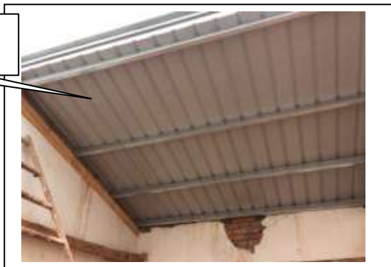
Fin de la pose des tôles
