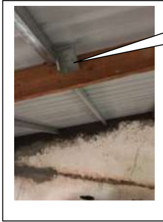
Renforcement des pannes avec des bouts de pannes restantes
