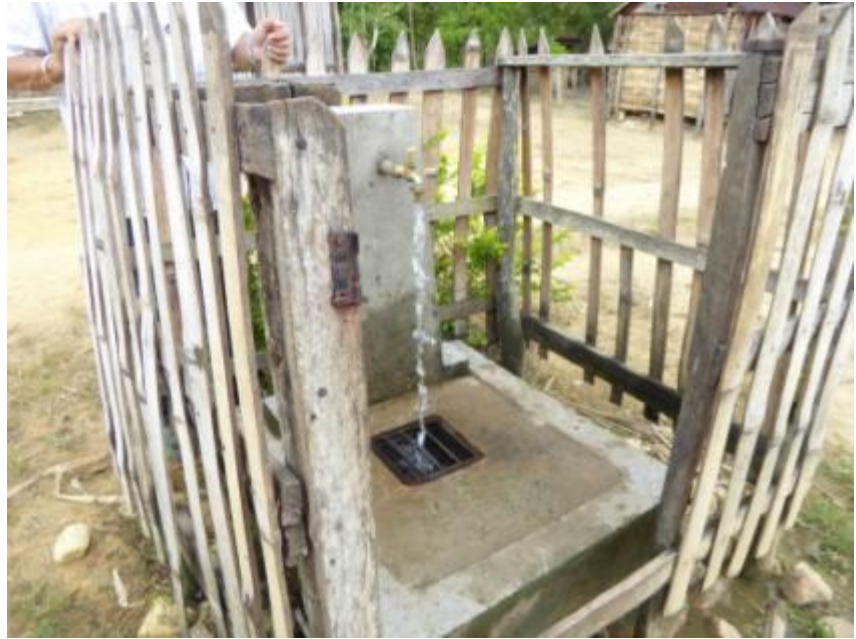
Etat inégal des bornes, problème de la rouille des tuyaux incorporés dans la maçonnerie
