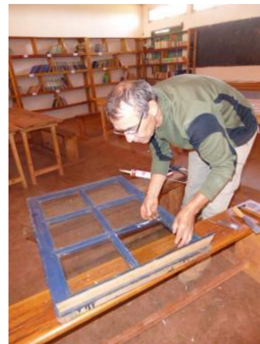
Dépose des vitres cassées et grattage du mastic réalisé par des fils de parents d'élèves.
