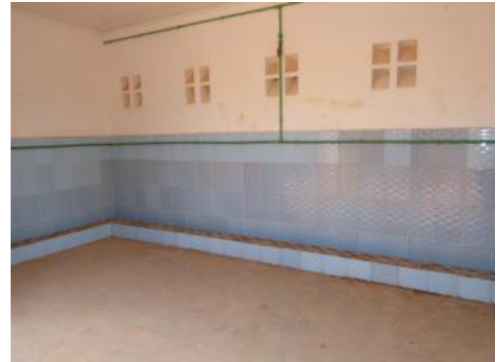
Pissoir avec rampe d'eau qui goutte
