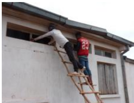
Dépose des vitres cassées et grattage du mastic réalisé par des fils de parents d'élèves.
