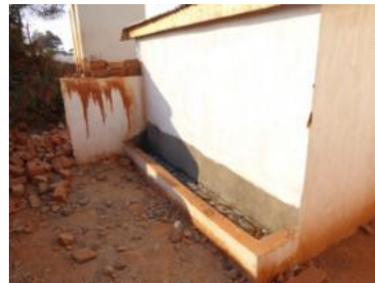
Petit bloc latrines-pissoir construit sur ancienne fosse
