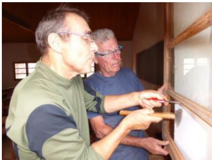
Dépose des vitres cassées et grattage du mastic réalisé par des fils de parents d'élèves.
