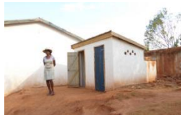
Petit bloc latrines-pissoir construit sur ancienne fosse
