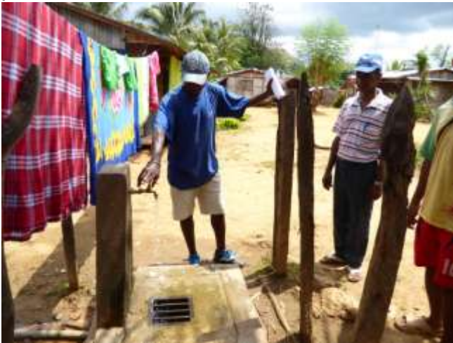
Autre borne de ce village alimentée en eau, branchement direct, pas de vanne, aucune protection autour
