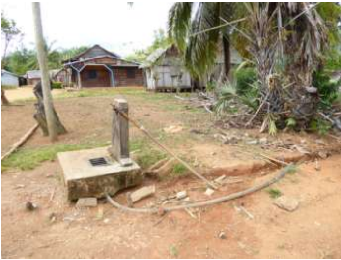
Autre borne de ce village alimentée en eau, branchement direct, pas de vanne, aucune protection autour
