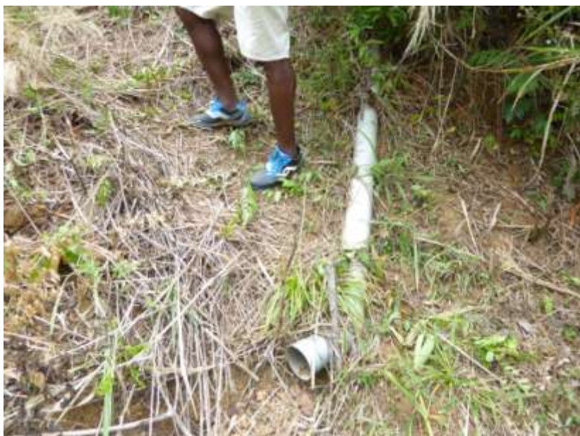
Débit correct d'arrivée d'eau dans le réservoir
