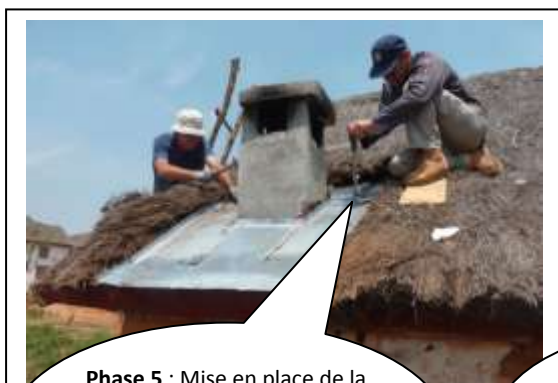
Phase 5 : Mise en place de la tôle supérieure, et fixation des tôles entre-elles à l'aide de rivets pop.
