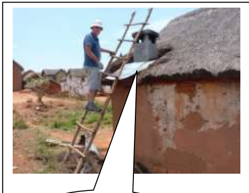
Phase 1 : Dépose du chaume et présentation de la tôle.
