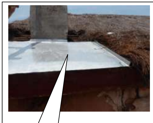
Phase 2 : Découpe et pose du premier morceau.
