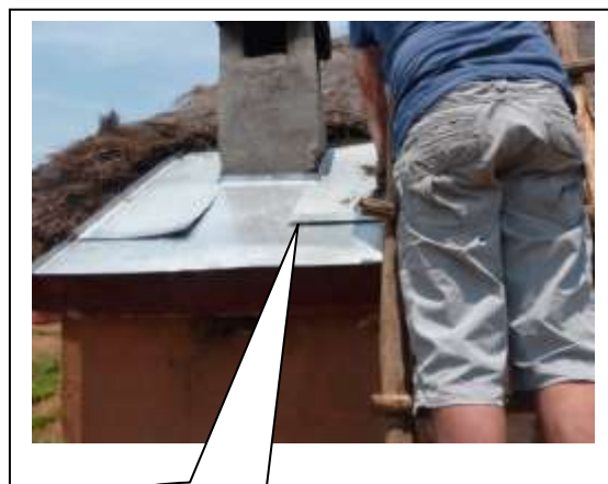
Phase 4 : Pliage des 2 tôles latérales afin de canaliser l'eau
