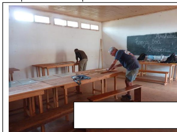
Préparation avant la pose des vitres
