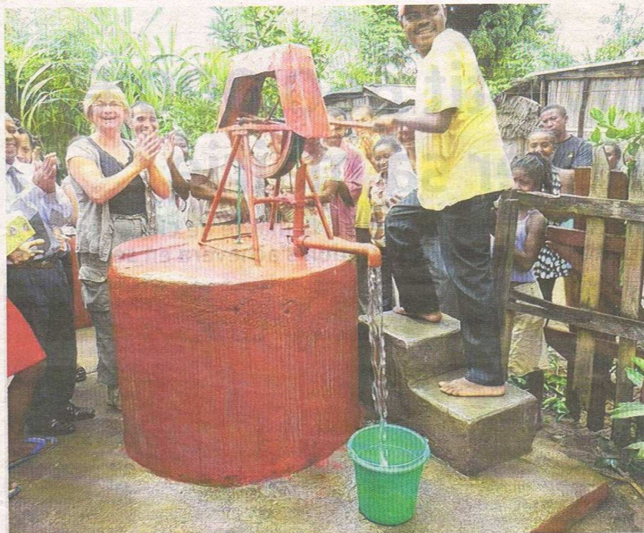
L'inauguration du puits à Sambava (nord est du pays) lors du dernier séjour en date de l'association avec un groupe d'adhérents en octobre 2011.
